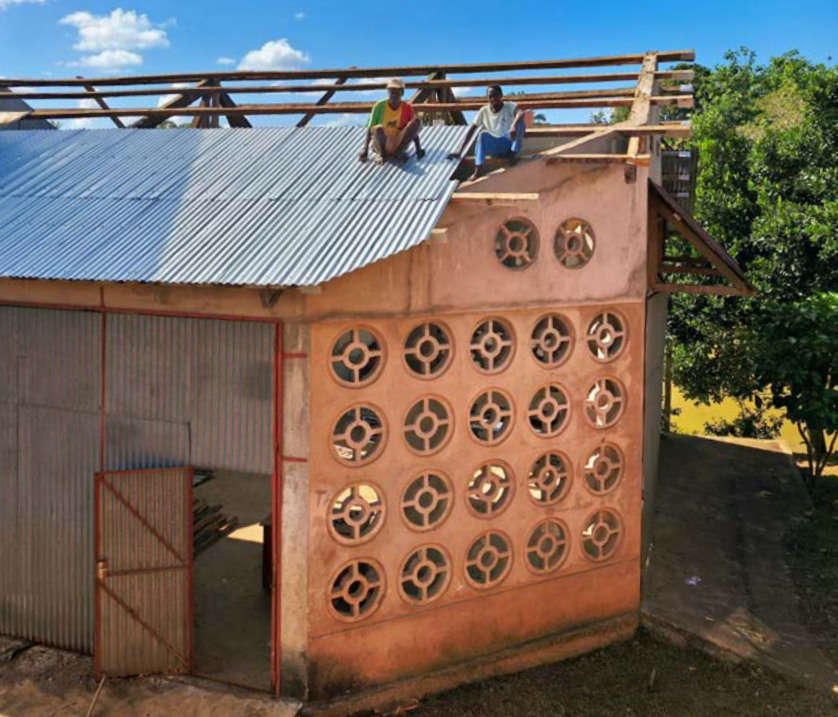
● Obnova streh na objektih v Matangi
