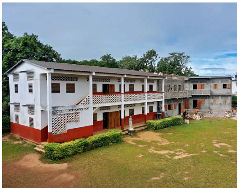
● Nov prizidek k šoli v Manambondro iz Trikralsjevske akcije
